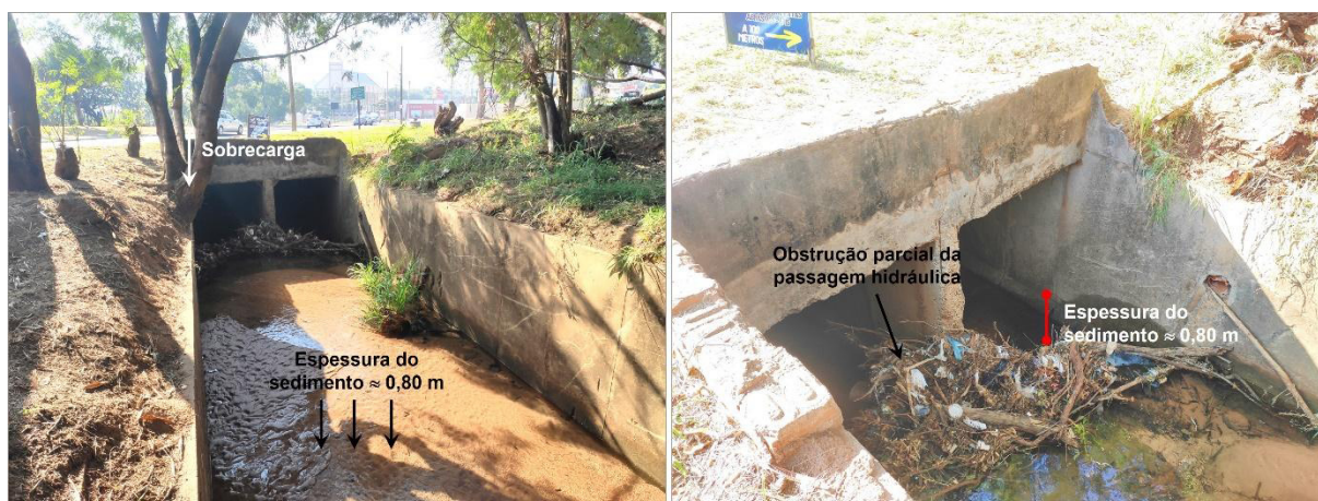
Figura 6. Trecho canalizado à montante do Trecho 2 com obstrução da passagem hidráulica e consequente deposição de sedimento oriundo de processos erosivos nas margens e fundo do Córrego Água do Sobrado. Fotografias: Vallis E&A, 2024.
