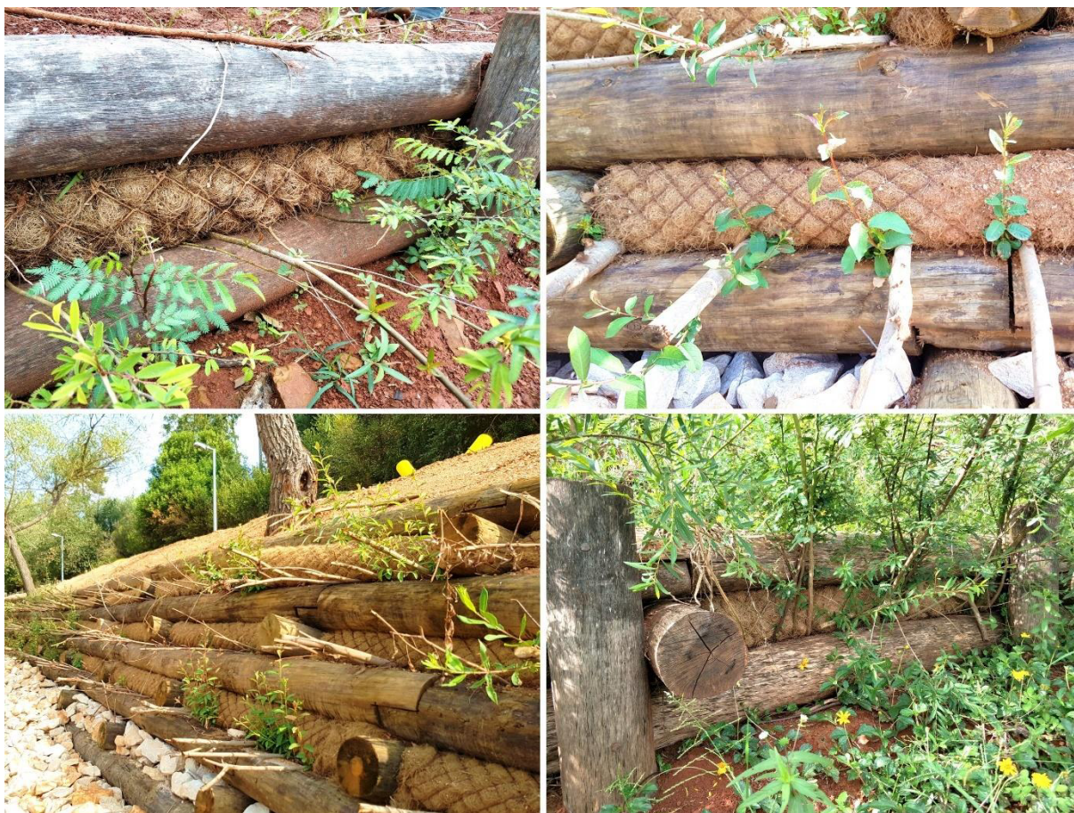
Figura 14. Detalhes do posicionamento de biorretentores de coco e mudas arbustivas dentro de muros de suporte vivos. Fotografias: Rita SOUSA e Junior DEWES.
