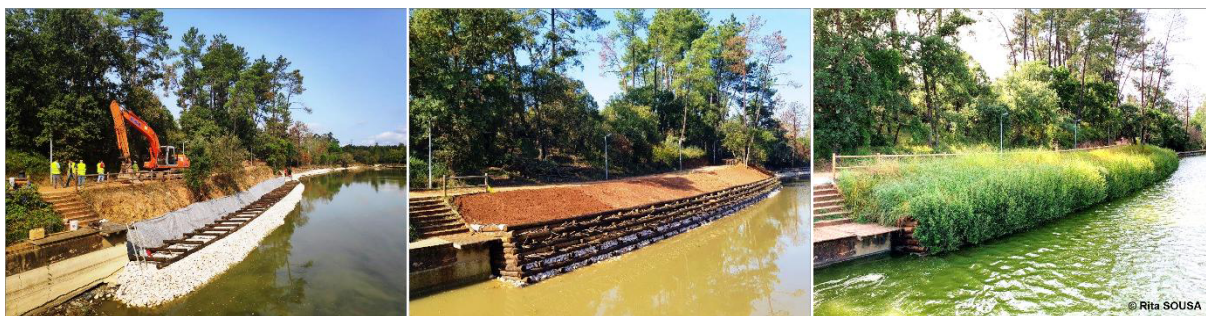
Figura 13. Evolução de enrocamento e muro de suporte vivo parede dupla executado para consolidação e revitalização de talude fluvial em âmbito urbano. Fotografias: Rita Sousa.
