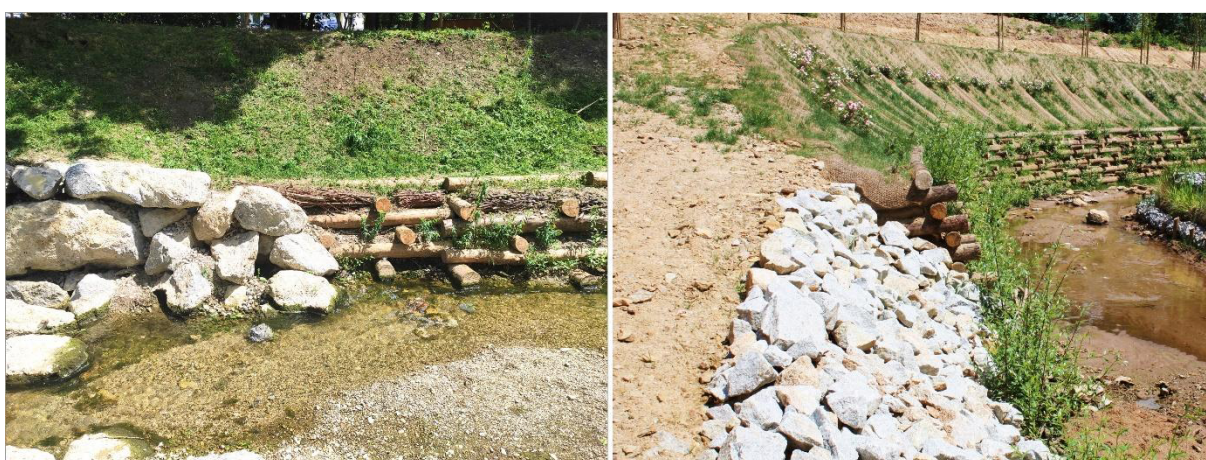
Figura 15. Exemplos de obras de Engenharia Natural com detalhe da interface entre o enrocamento e o muro de suporte vivo. Fotografias: Rita SOUSA e Junior DEWES.
