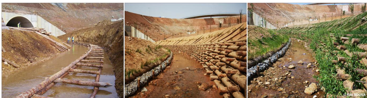
Figura 12. Evolução de muro de suporte vivo parede dupla executado para consolidação e revegetação de talude fluvial. Fotografias: Rita Sousa.
