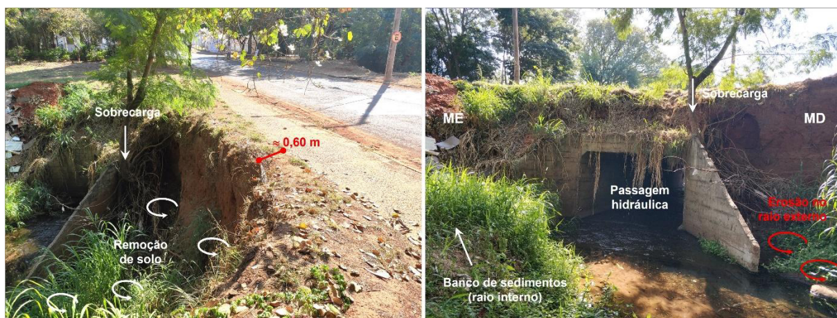
Figura 5. Margem direita do Trecho 1 com processo erosivo e remoção de solo na parte posterior do muro ala (à esquerda) e vista geral do córrego na parte final do trecho com banco de sedimentos à esquerda e erosão no raio externo na margem direita (à direita). Fotografias: Vallis E&A, 2024.
