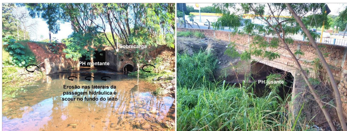
Figura 9. Trecho 2 – Vista para montante com destaque para os processos erosivos nas laterais da passagem hidráulica (à esquerda) e vista para jusante (à direita). Fotografias: Vallis E&A, 2024.
